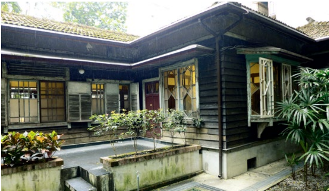
圖 4 | 臺北市青田街日式屋舍一樓地板皆有抬高，並留有通風管道。 作者攝
