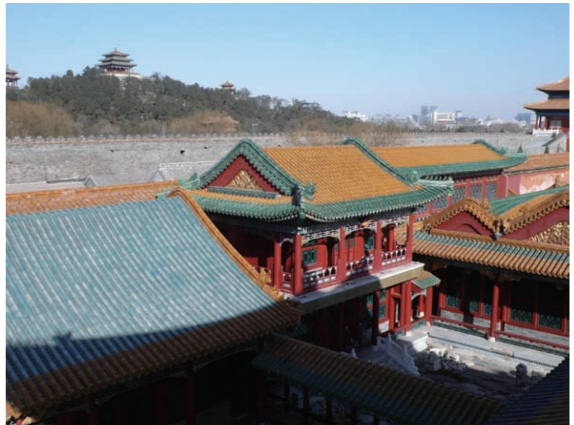
圖十八 《畫太簇始和》畫中敬勝齋的屋頂被前方延春閣遮蔽，東邊為有脊硬山頂，而重建之敬勝齋東西邊皆為卷棚頂。站在延春閣二樓廊上，可見到敬勝齋、吉雲樓、慧曜樓與靜怡軒屋頂。透過高大宮城牆垣，可看到景山公園。(林莉娜攝影)
