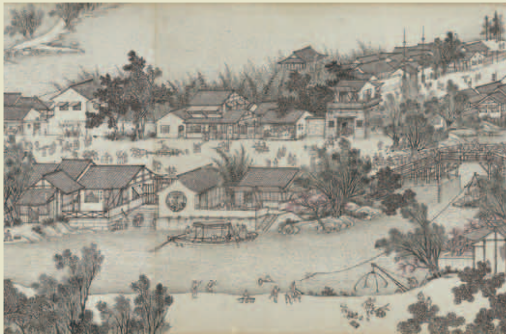
圖八-1 沈源本八字橋下情景
