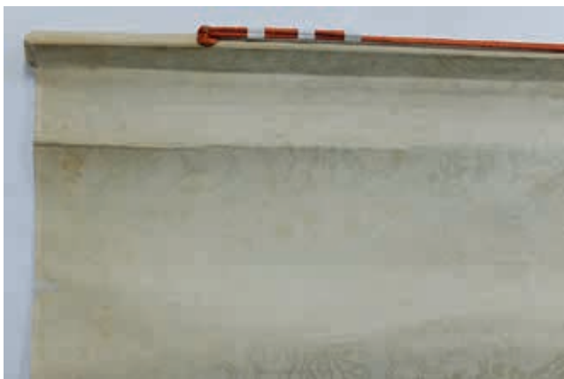
圖5 修護前 天綾劣化狀況 登錄保存處修護紀錄
