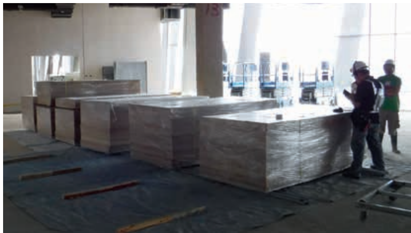
圖6 加熱後的木料運抵南院現場，等待進展場施作前的最後抽驗。作者提供
