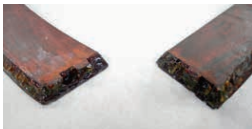
圖11 不明合成樹脂敷塗丙酮凝膠 登錄保存處修護紀錄
