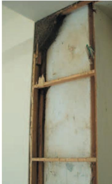
圖四 地下白蟻建巢於建築物的隔間牆內，由壁面油漆剝落情況可知該區域先前有漏水而造成局部潮濕問題。
