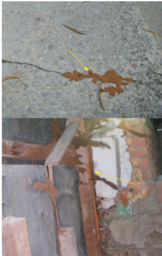
圖五 地下白蟻會循著建築物裂隙或現成的管道空間向上入侵建築物內部。
