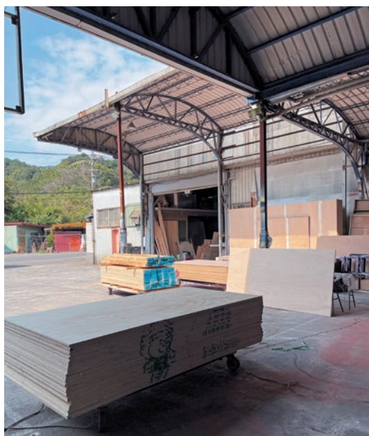
圖 5 木材廠和加工廠多半設於郊區，材料存放在半開放式廠房空間。作者攝
