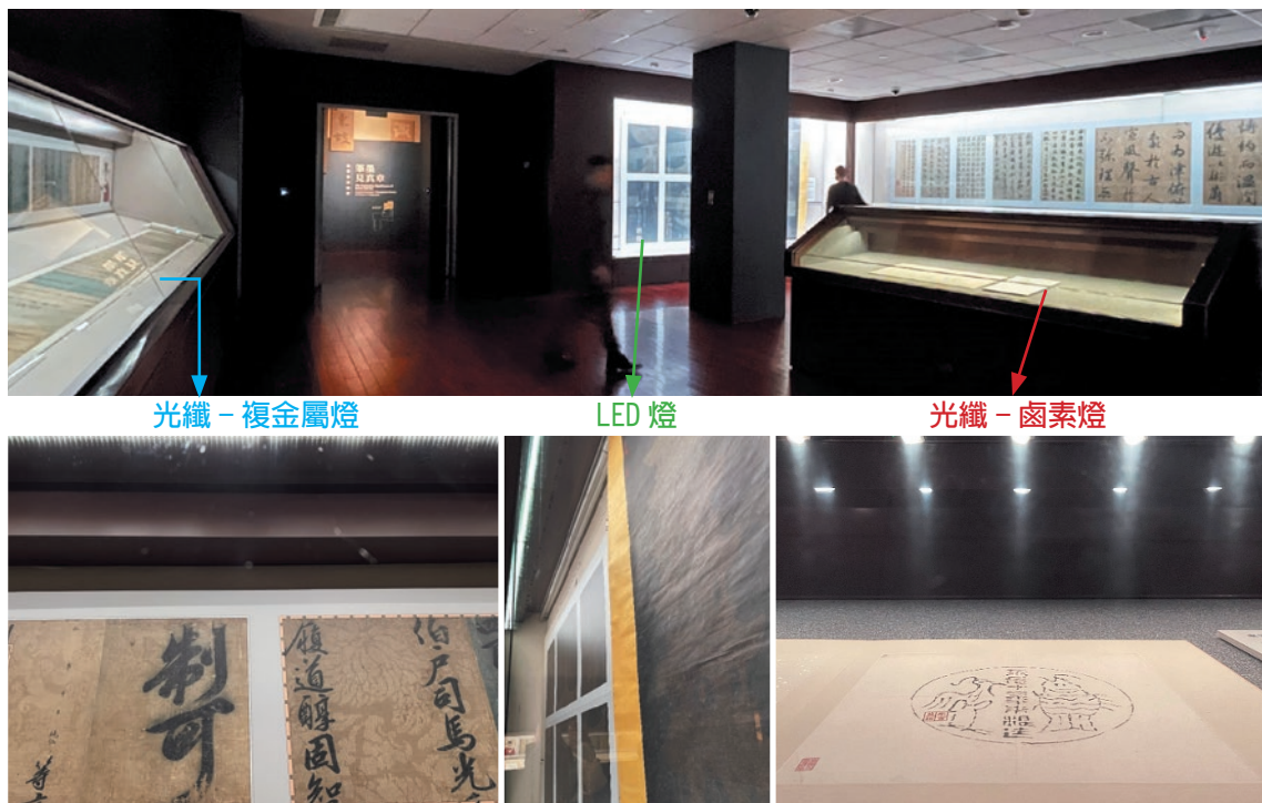
圖 5 書畫陳列室文物照明燈具三代並陳，先後順序為右前櫃：光纖系統搭配石英鹵素燈源（色溫約 3450K）；左櫃：光纖系統搭配複金屬燈源（色溫約 3650K）；右後櫃：LED 燈（色溫約 3900K）。作者攝
