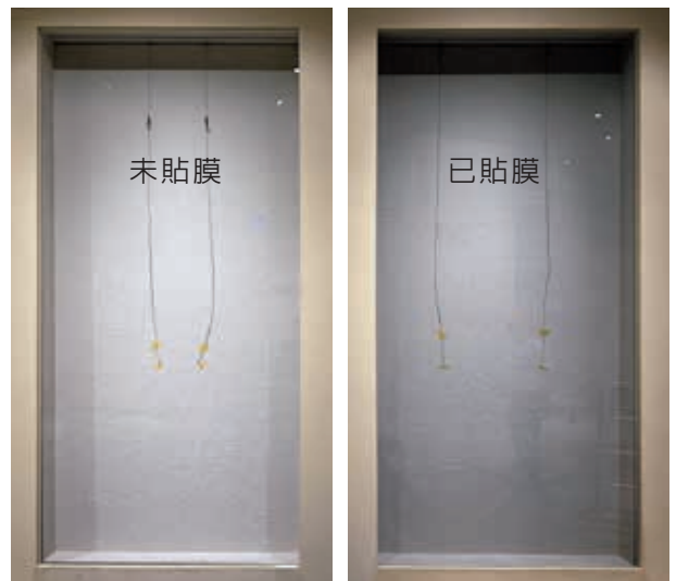
圖4 南部院區 S203 展廳施作貼低反射膜之現場，已完成貼膜之右側 PC 板因反射較少光線明顯較暗。李宥欣攝
