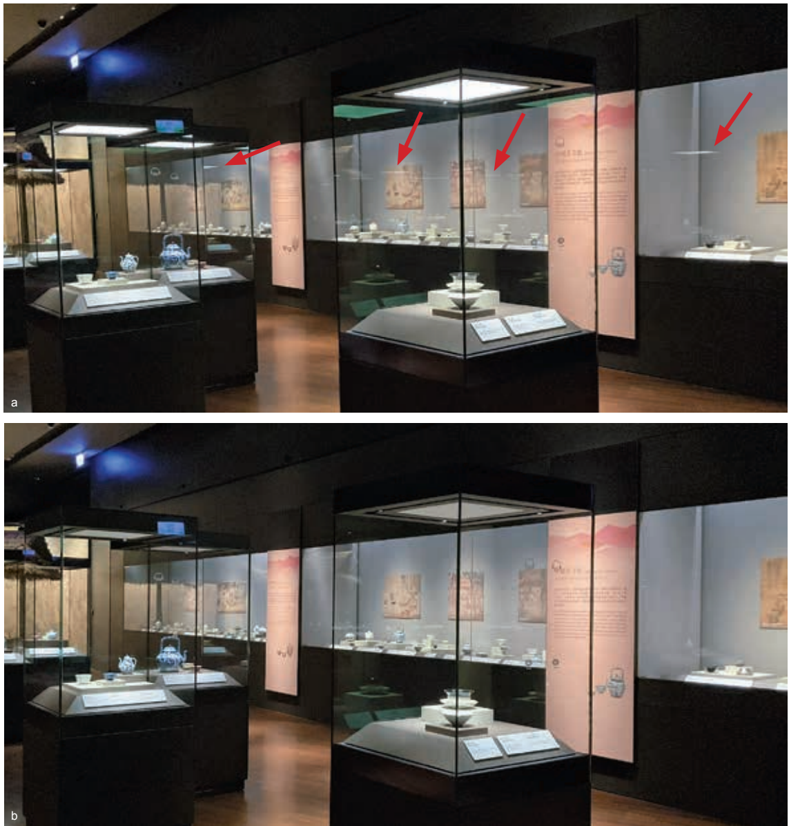
圖 5 a. 南部院區 S202 展廳之獨立展櫃使用櫃內平板燈時，將於邊櫃玻璃上出現明顯之燈板倒影。 作者攝影製作 b. 獨立展櫃不使用平板燈時，邊櫃玻璃上的倒影明顯獲得改善。 作者攝影製作
