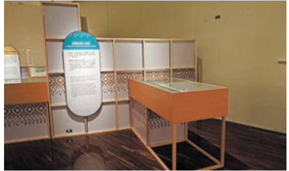
圖 47 展場製作尺寸方形量化，木結構角材裸露，清晰可見其上的釘孔，展櫃製作僅做最小尺寸，與文物安全需求的必要包覆，見以減少材料使用與表面塗佈的永續精神。 作者攝
