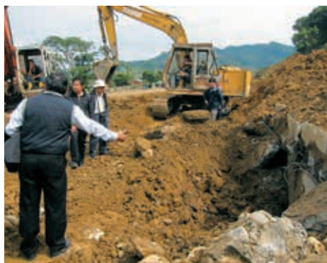
圖1 北溝山洞封存後的開挖現場 余貞暉攝
