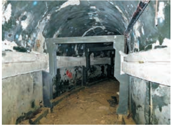
圖20 混凝土門型框架結構 取自臺中市文化資產處： https://www.tchac.taichung.gov.tw/historybuilding?uid=34&pid=3 ，檢索日期2022年5月10日。
